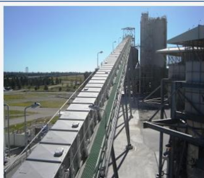
Manipulation des cendres résiduelles sèches dans les centrales électriques PCF ✨
