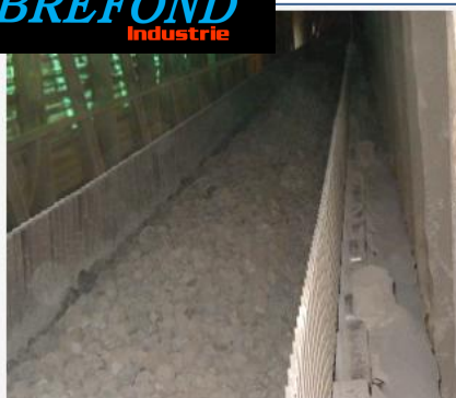
Convoyage de clinker chaud
